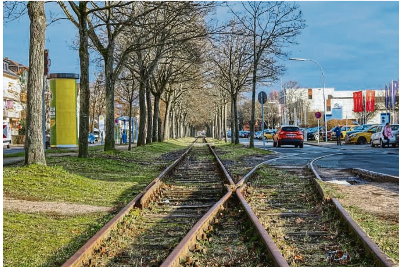
Der Vorteil der RTW-Planung in Neu-Isenburg ist, dass das vorhandene Gleis in der Carl-Ulrich-Straße genutzt werden kann. Der Abzweig ins Industriegebiet wird nicht genutzt.
